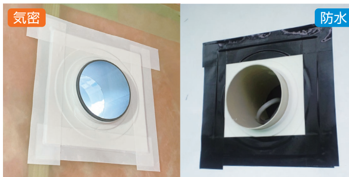
ドームパッキン周りの気密・防水処理
