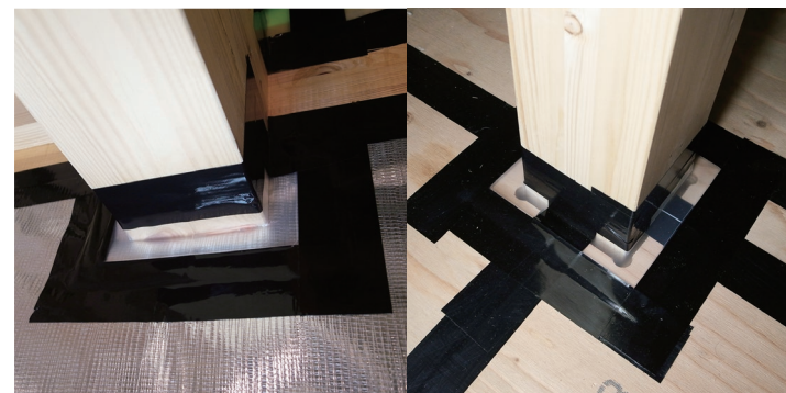
気密柱バリアー梁・床下周りの気密処理
