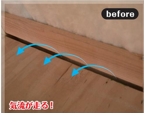
↑取合い部未処理により、壁内結露・隙間風の原因に
