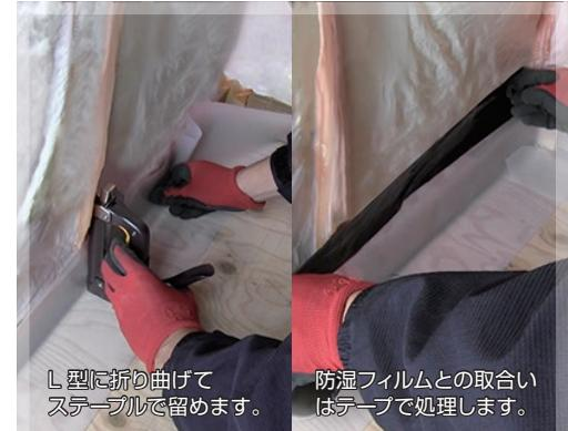
↑折れ線でL型に折り曲げ、簡単取付け
