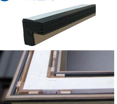
L字がフィットしてしっかりと納まるため美観を損ねず確実に換気
