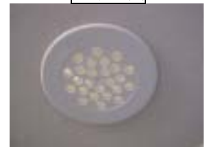
天井設置写真
