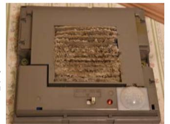
ダクトレス換気のフィルターは汚れやすく、大幅な換気風量の低下につながる
