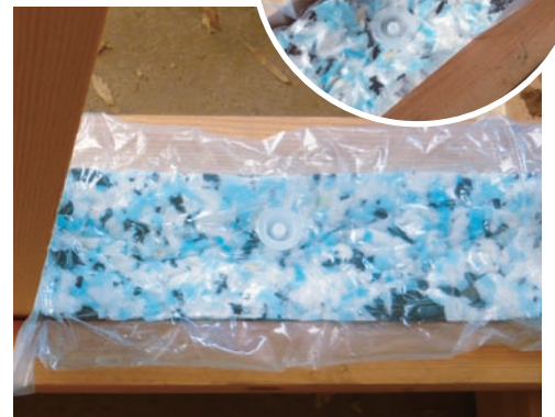
現場で施工した様子
