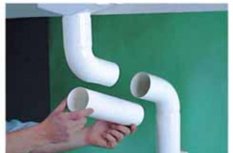
⑫エルボとエルボの継ぎは、ドレンパイプをカットして使います。※これも接着してはいけません。
