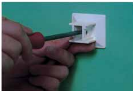
⑪じょうごにエルボをセットしてドレンパイプを継ぎます。ホルダーはドレンパイプ(3m)上下の端につけしっかりと壁に固定します。ドレンの継ぎはソケットを用意しています。※ドレンの継ぎは接着剤を使用してはいけません。
