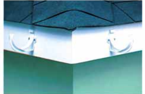
③コーナーから203mm以上離して、両側にブラケットを取り付けます。
