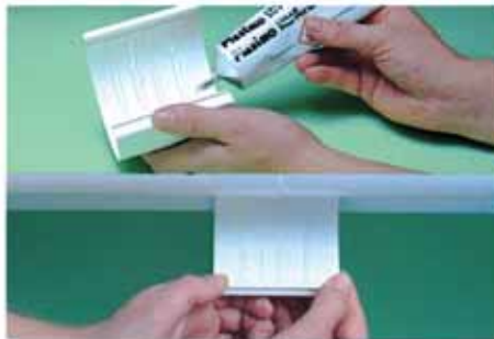
⑧樋の継ぎ目はジョイントで補強します。
