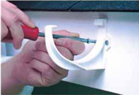
①ブラケットを取り付けます。雨勾配は3mm/mです。
