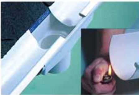
⑦じょうごに落ち込む樋の両サイドを火で炙って柔らかくし凹をつけます。樋の長さのカットは、じょうごの温度指示通りとします。※じょうご樋の接着は厳禁です。
